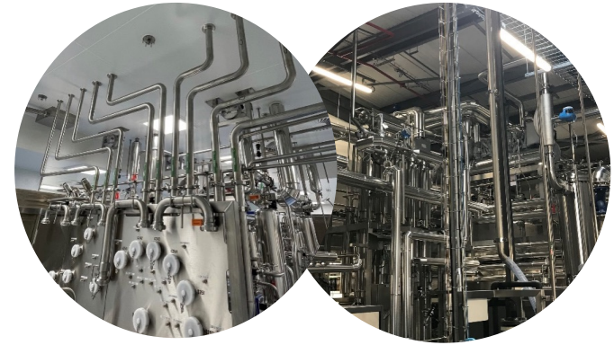
Des installations de tuyauteries process (Clean piping) Distribution de Boucles d'eaux
